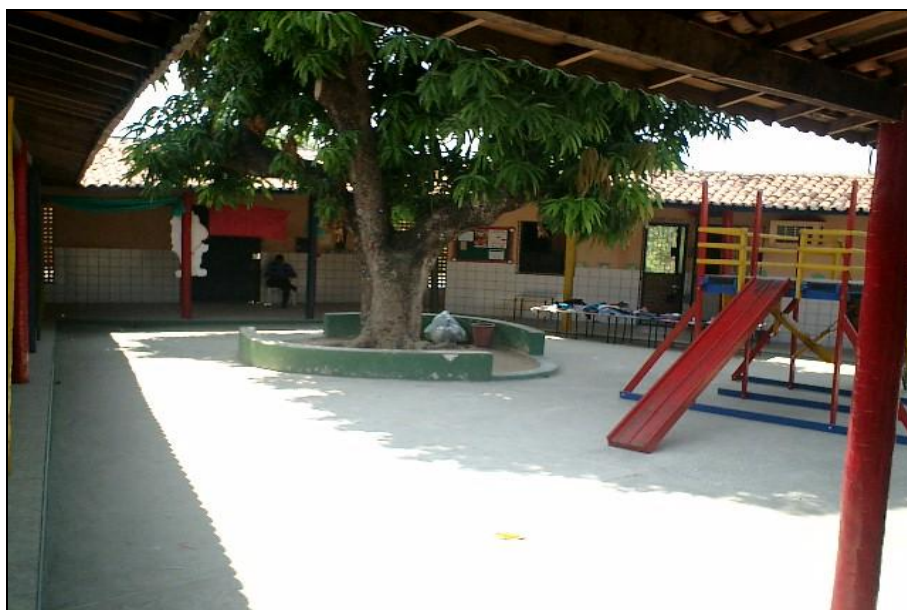
FOTO 15 – Pátio interno com e sem sombra, pavimentado, com mangueira contida por mureta. Parque infantil instalado em piso pavimentado. (CEI Narizinho).
