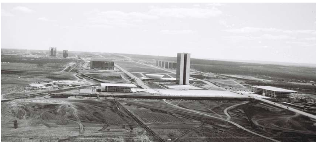
Figura 83 – Modernismo de tábula rasa em ação, na construção de Brasília. (PODER 360). Disponível em: < https://www.poder360.com.br/brasil/veja-fotos-de-brasil-ia-durante-a-construcao-e-como-a-capital-esta-agora/#gallery-modal-460605 >. Acesso em 21 de jan. de 2022
